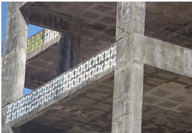
**Fig. 2:** Stencil aplicado ao concreto do “predinho”.
